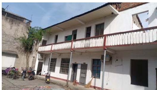
南侧现状建筑
