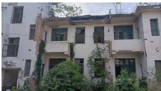
北侧现状建筑
