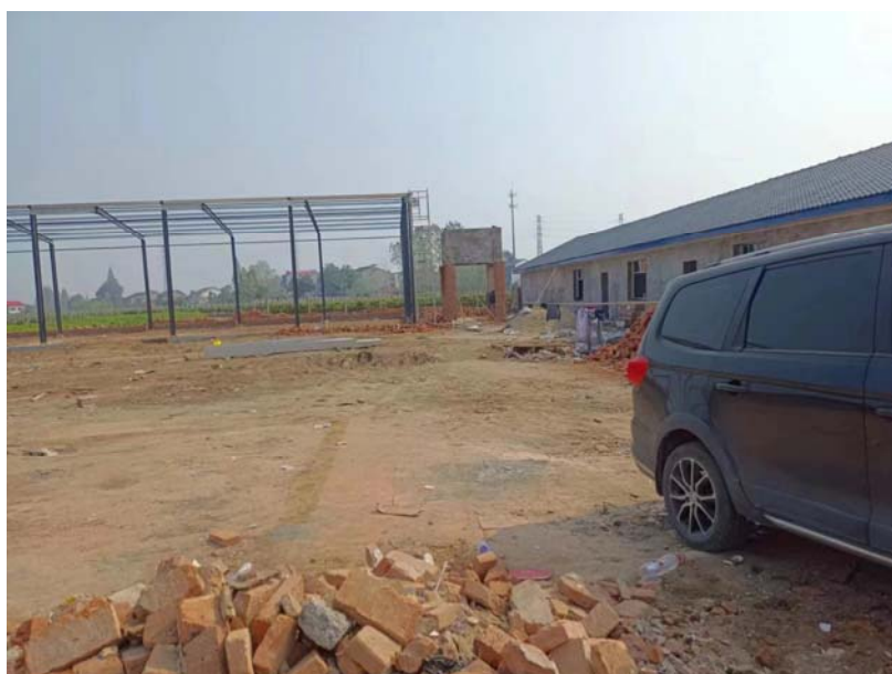
地块内部情况（部分建筑已拆除）
